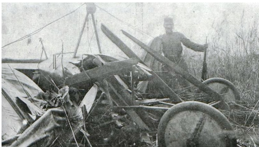
13.93. Restos del Monocoque II accidentado en el Prat de Llobregat 321
